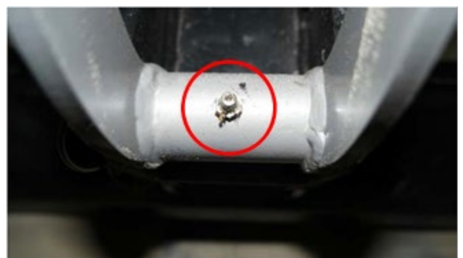
Fig. 21: Bult koppling 2 i skopan.
