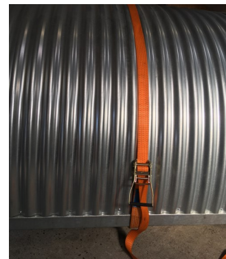
Figur 1-14: OBS! Brug en båndstrammer til montage af pladerne, både ind- og udvendig. Så de bliver klemt helt sammen.
