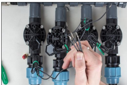
Tag en ledning fra hver magnetventil
